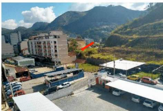
Figura 3: (a) foto no ano de 2014 com parte do prédio destruído pelo movimento de massa e gabiões na encosta; (b) prédio reconstruído em 2018.
