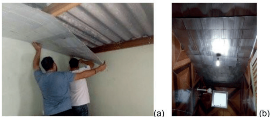
Figura 5. Instalação das placas nas residências contando com o auxílio do morador (a) e cômodo com forro já finalizado (b)
