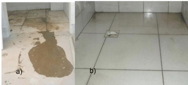
Figura 5. Caimento inadequado em piso cerâmico em boxes de banheiros.
