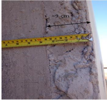
Figura 4. Emboço em parede de alvenaria em desaprumo.
