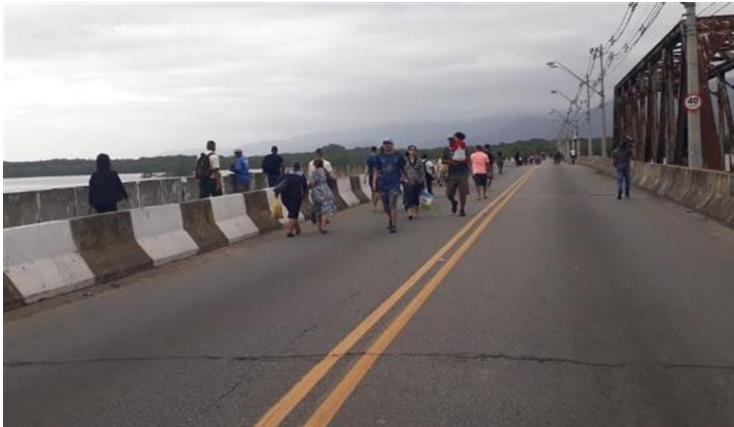
Figura 1 – Ponte dos Barreiros
