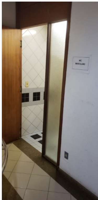
Figura 2 – Corredor de acesso ao Banheiro do piso térreo do prédio I da Reitoria UFSC
