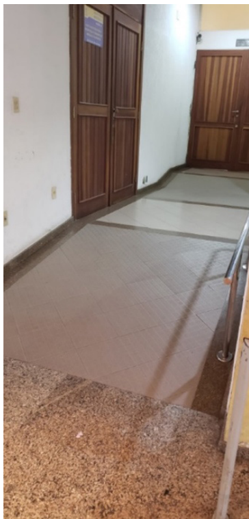
Figura 1 – Rampa de acesso ao Banheiro do piso térreo do prédio I da Reitoria UFSC
