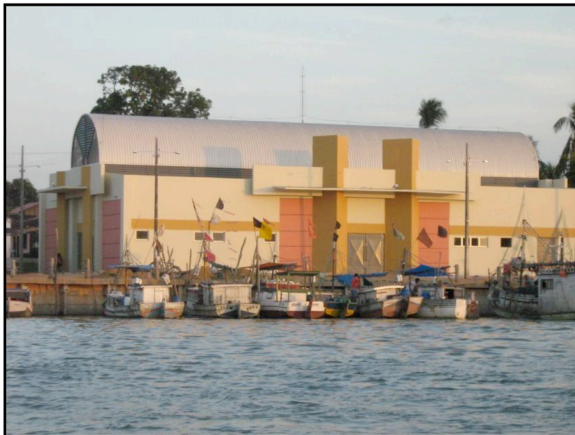
Figura 2: Mercado municipal da vila do abade-Curuçá-Pa.
