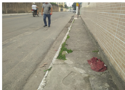
Figura 4 - Calçadas estreitas, precárias e sem sinalização tátil.
