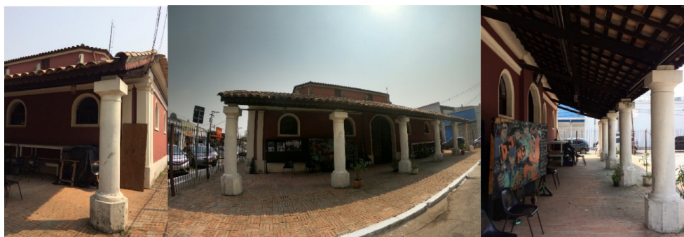
Figura 6a, b e c – Detalhes colunas que sustentam o alpendre.
