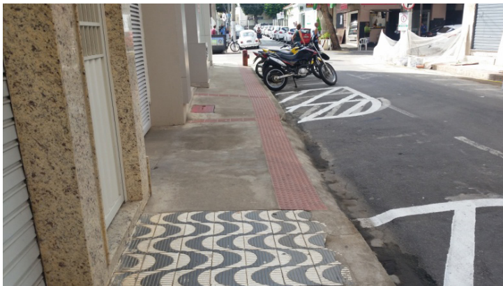
Figura 12 – Descontinuidade do podotátil.
