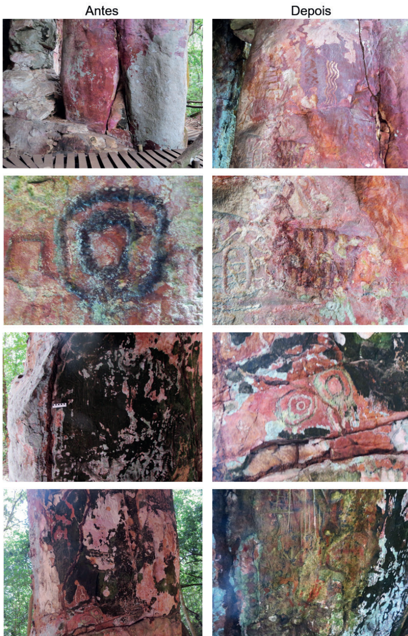
Figura 8 - Etapas de conservação com os resultados do antes e depois das intervenções
