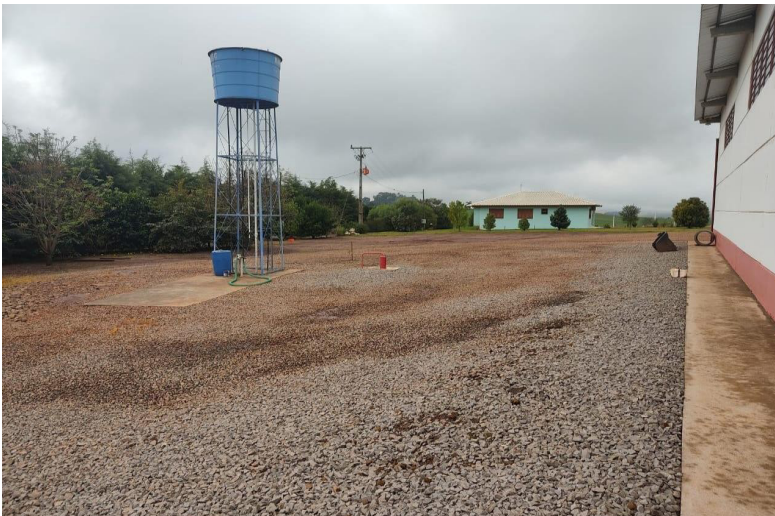
Figura 6: Local de construção do armazenamento de combustível.
