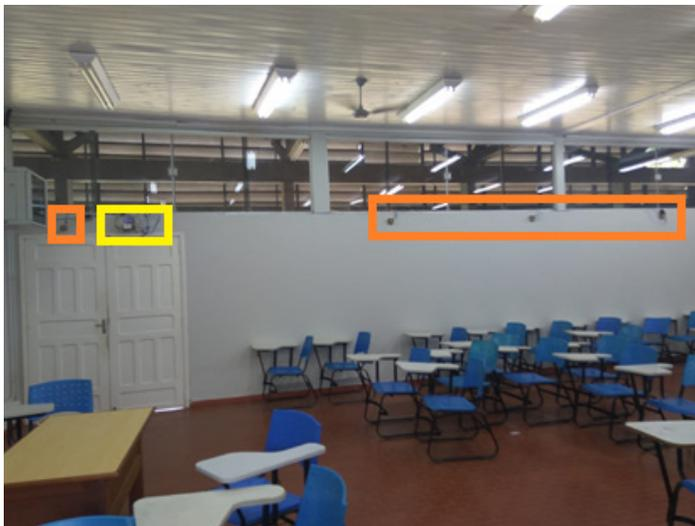
Figura 6: Instalação do protótipo em sala aula. Em laranja os sensores de presença do tipo PI, em amarelo o protótipo de automação.
