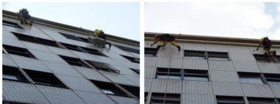
Figura 9: Ensaio de Percussão
