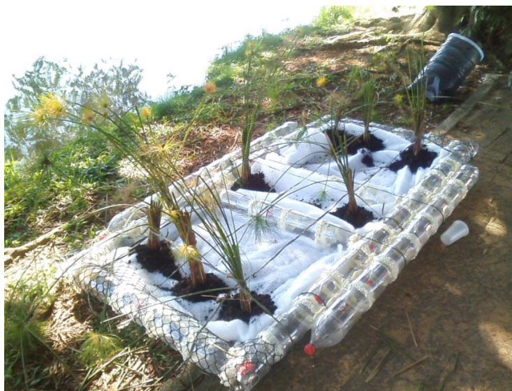
Figura 6 - Plantio das mudas de macrófitas emergentes e substrato inicial.
