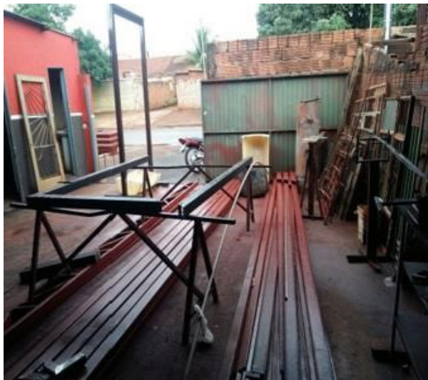
Figura 4 - Armazenamento Inadequado das Vigas Metálicas
