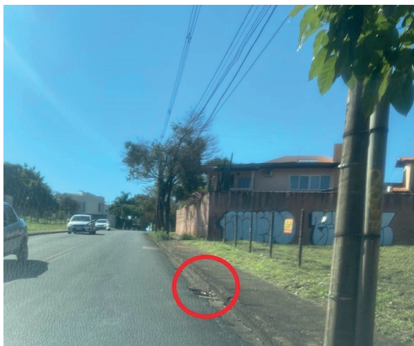
Figura 5 - Registro da única boca de lobo da rua.
