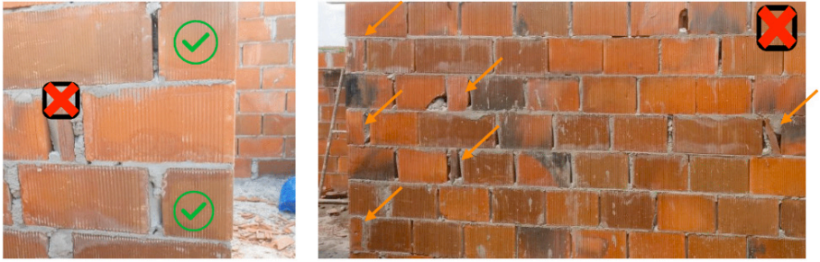
Figura 06: Utilização de um bloco inteiro no lugar de meio bloco
