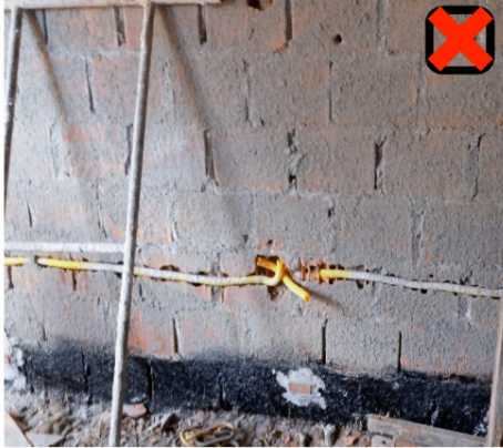
Figura 05: Rasgos para passagem de eletrodutos
