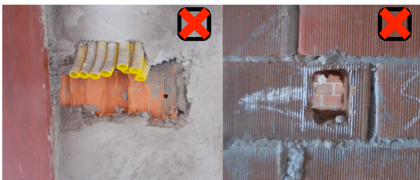
Figura 04: Rasgos para colocação de caixas elétricas
