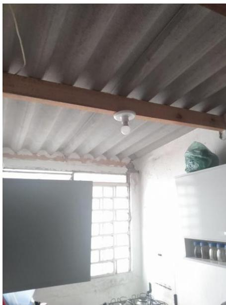
Figura 2 – Sistema de cobertura em telhas de fibrocimento utilizado pela Habitat Brasil
