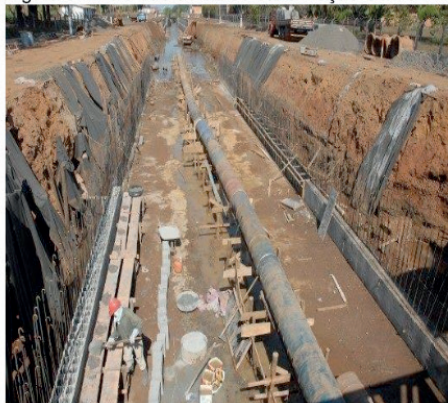
Figura 5: Início das obras de canalização Gamelinha
