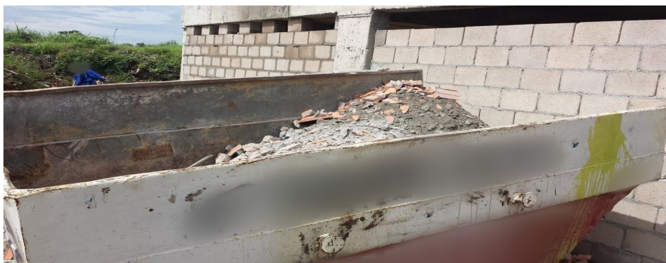
Figura 5 – Containers para armazenamento de RCC na obra 2.
