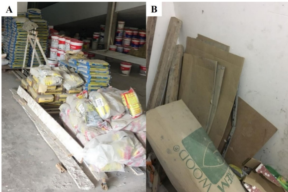
Figura 2 – Separação de materiais (A); Separação de resíduos (B).
