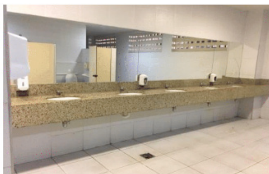
Figura 43: Sanitário de Serviço – Docas Fonte: as autoras.
