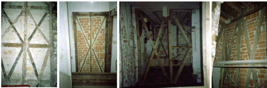
Figuras 5, 6, 7, 8 -Paredes tradicionais. Fases de reabilitação: fechamento de vãos e construções de novas paredes resistentes segundo os princípios da construção pombalina. (Reaes Pinto)
