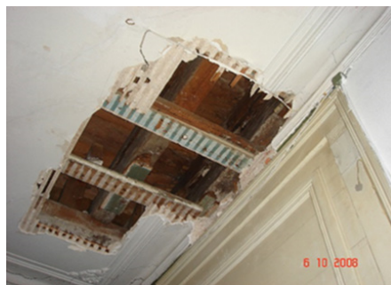
Fig 4 - Tecto estucado degradado (Reaes Pinto)
