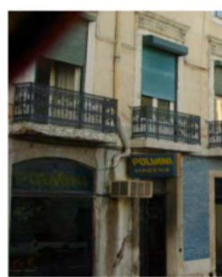
Fig 2 - Pormenor de fachada (Reaes Pinto)
