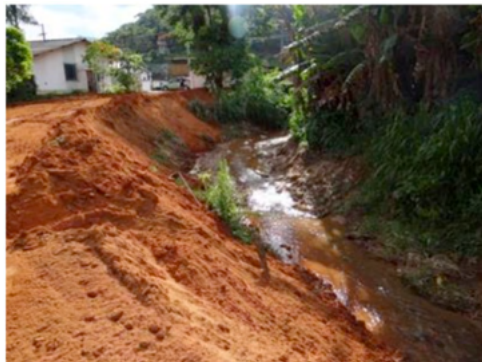
Figura 4: Ampliação da margem esquerda do córrego.
