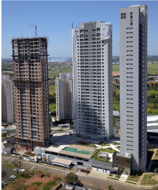
Figure 74 - Triade Condominium under construction, Brasal Incorporações, Uberlândia - MG. Source: www.brasal.com.br , accessed on 2019, April 17.
