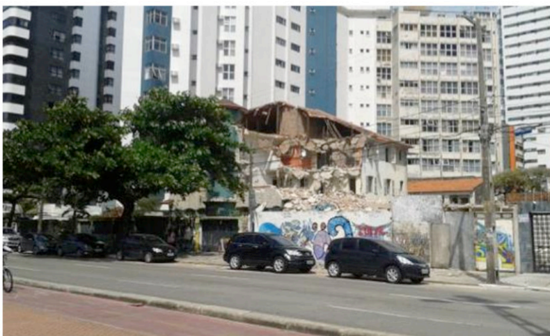
Figura 07. Registro do estado primeira tentativa de demolição do Edifício Caiçara em 2011, suspensa através de decisão judicial. Fotografia: Maria de Lourdes Nóbrega.
