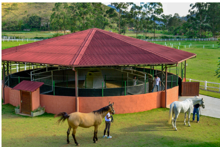
Figura 5 - Estrutura de concreto - Coberta.
