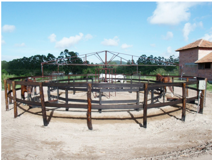
Figura 4 - Estrutura de madeira
