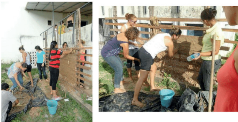
Figura 1- Canteiro experimental da disciplina de Técnicas Construtivas Tradicionais – Taipa de mão ano 2012
