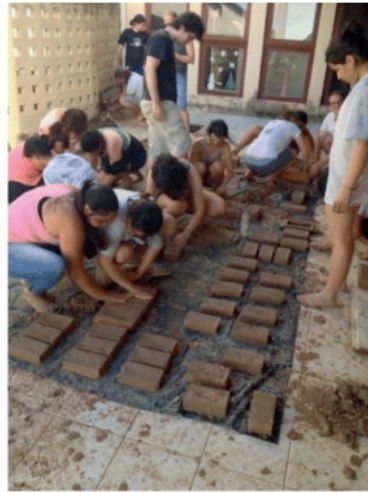
Figura 3 -Canteiro experimental da disciplina de Técnicas Construtivas Tradicionais –Adobe ano 2013.2
