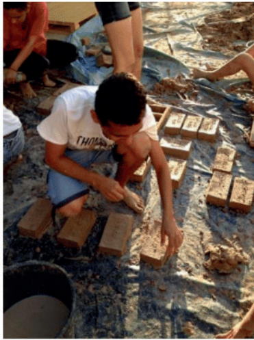
Figura 3 -Canteiro experimental da disciplina de Técnicas Construtivas Tradicionais –Adobe ano 2013.2
