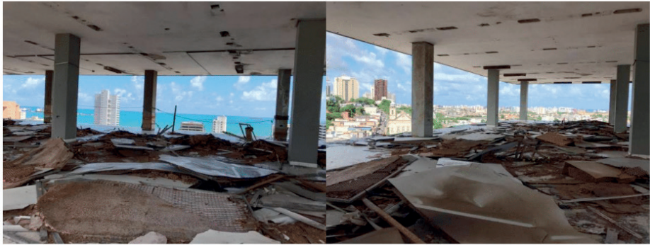
Figura 2 – Vista interior do Edifício Palmares a partir de um de seus pavimentos.
