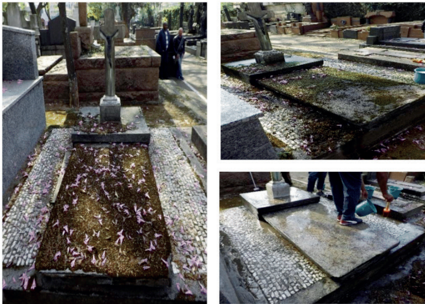
Figura 5: Jazigo escolhido para a oficina de limpeza e conservação
