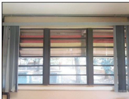
Figura 3 – Janelas da biblioteca voltadas para o exterior do edifício.
