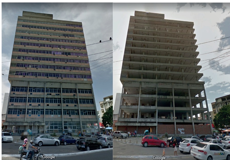
Figura 1 – Edifício Palmares em Abril de 2015 (Esquerda) e Agosto de 2016 (Direita)
