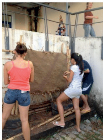
Figura 2 - Canteiro experimental da disciplina de Técnicas Construtivas Tradicionais – Taipa de mão ano 2013.1
