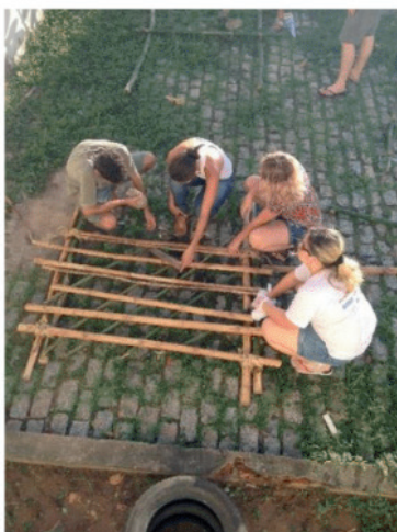
Figura 2 - Canteiro experimental da disciplina de Técnicas Construtivas Tradicionais – Taipa de mão ano 2013.1
