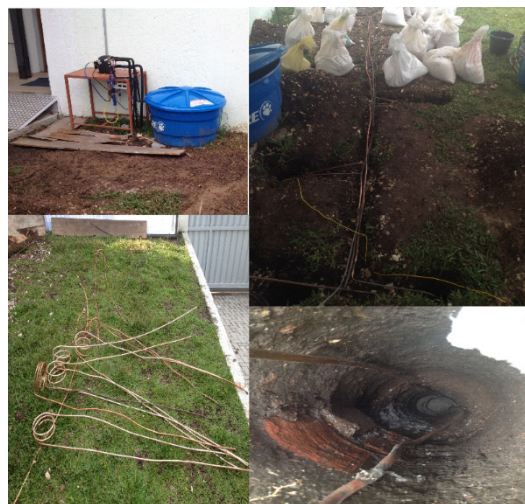
Foto 1 – Implementação do Ground Source (DX)
