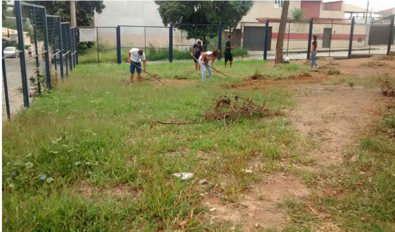
Figura 01: Limpeza e nivelamento da área
