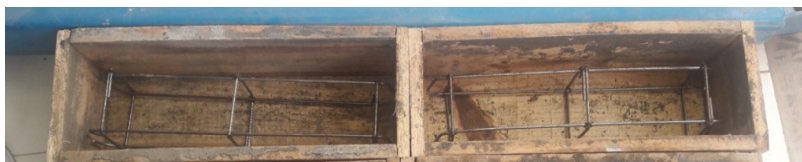
Figura 3 - Armaduras e fôrmas utilizadas (Autor)
