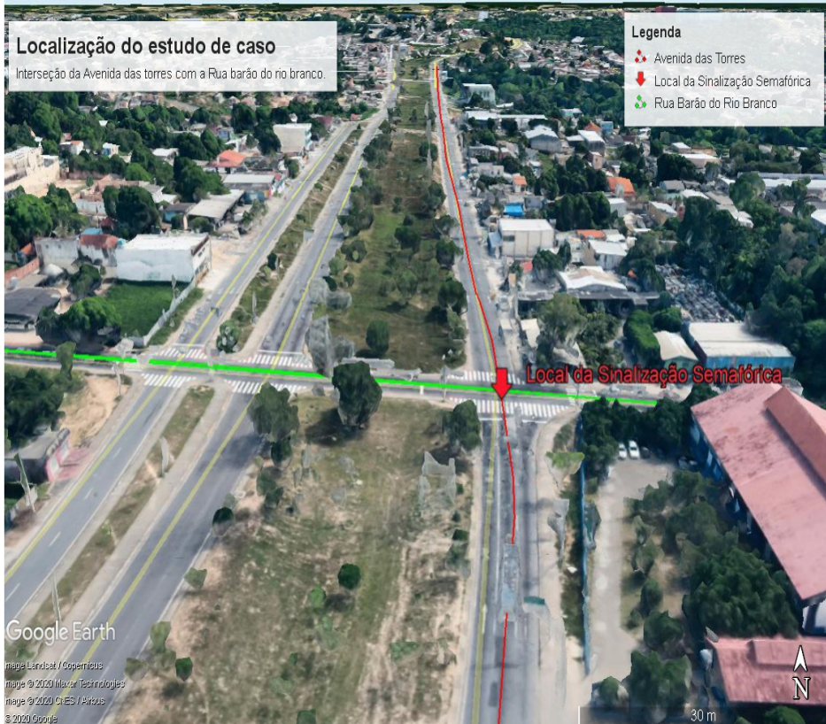
Figura 1 – Interseção da Avenida das Torres com a Rua barão do rio branco.
