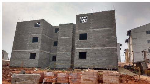
Figura 5 – Empreendimento em alvenaria estrutural.
