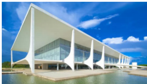
Figura: Palácio do Planalto, que exemplifica o tipo de estrutura superfície-ativa. Foto do Tourism Media.
