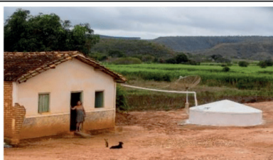
Figura 1- Cisterna de Cimento
