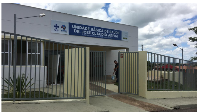
Figura 3 – Placa da UBS e Pintura Externa.
