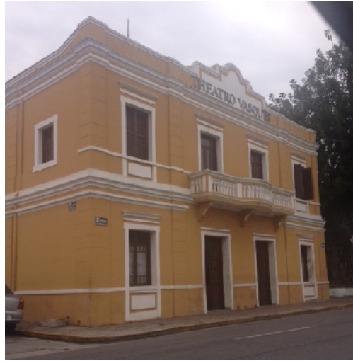
Figura 3. Teatro Vasques, construção de 1901.
