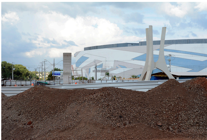
Figura 10 – Obras na rotatória do Boulevard Londrina Shopping, em 2019
