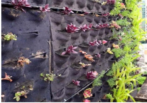
Figura 1 – Paredes vivas contínuas produzida em feltro imputrescível
