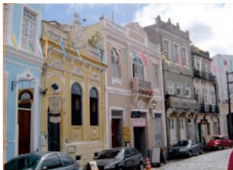
Imagem 13 – Etapa 6 Recuperação de 83 imóveis em Salvador
