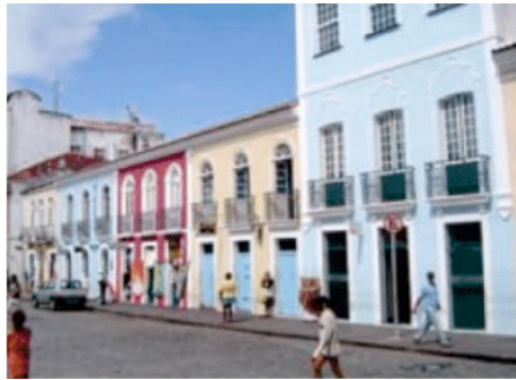
Imagem 14 – Etapa 4 Recuperação de 183 imóveis em Salvador
