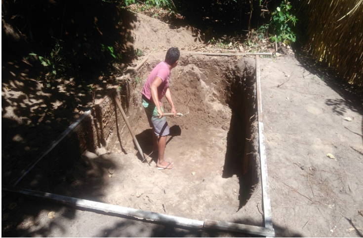
Figura 1: Escavação da trincheira para o TEvap.
