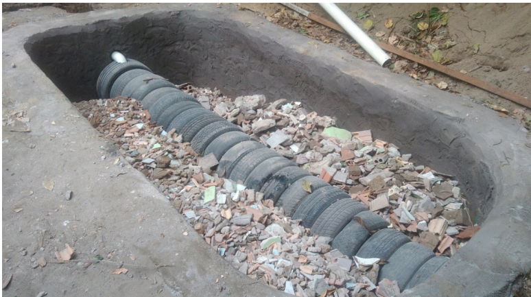
Figura 4: Colocação da camada de entulho de construção.
