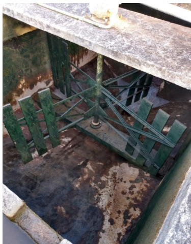
Figura 3 – Foto do floclador mecanizado de eixo vertical da ETA-TB.
