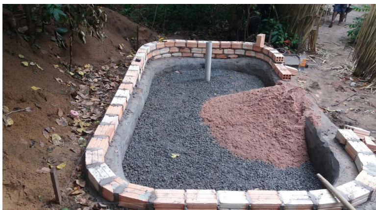
Figura 6: Adição da camada de areia.
