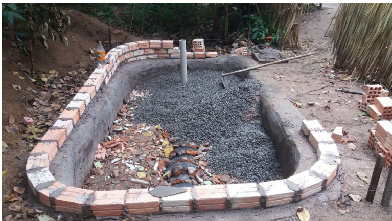
Figura 5: Adição da camada de brita.
