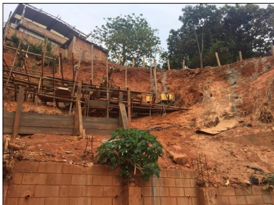
Figura 14. Encosta com intervenção do PEAR na Rua Delson Renault.
