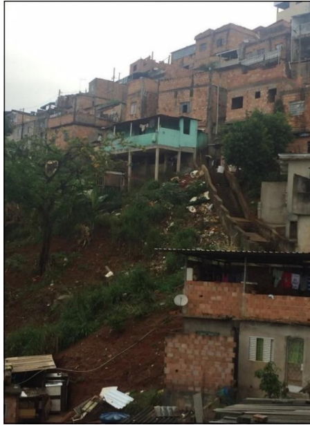
Figura 10. Encosta com alta declividade.
