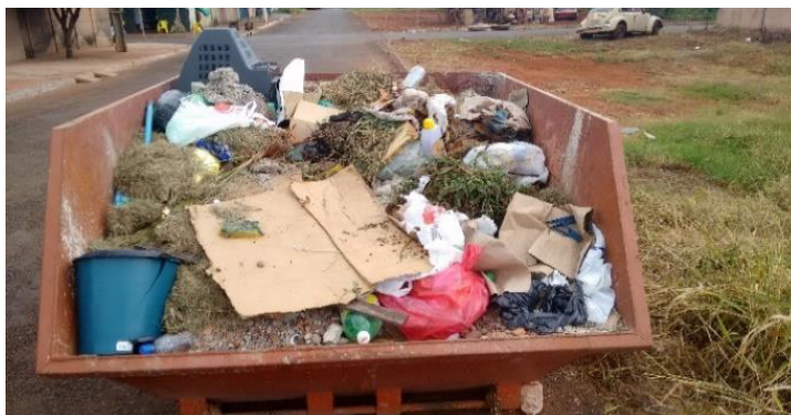
Figura 2 – Caçamba de Resíduos de Construção Civil sem a separação apropriada.
