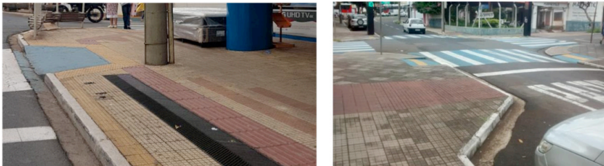
Figura 11: Acima: Araraquara Rua Nove de Julho (Sinalização tátil direcional e de alerta com diferenciação cromática. poste de iluminação locado incorretamente sobre a faixa de circulação, uso do espaço público para fins privados por parte de comerciantes locais). Abaixo: São Carlos - Cruzamento da Av. General Osório com Rua Riachuelo: Redução da travessia através de medidas de Traffic Calming . Fotos das autoras.
