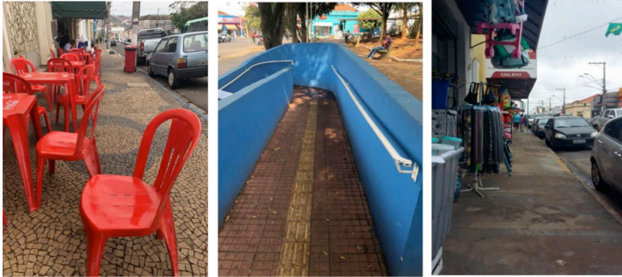
Figura 10: À esquerda Matão: Obstrução de áreas de circulação / apropriação indevida do espaço público para fins privados. Ao centro Matão: Rampa executada em área pública: interrupção no corrimão, alturas, empunhadura e tipologia incorretas, piso trepidante, instalação indevida e desnecessária de elemento tátil direcional sobre a rampa. À direita: Jaboticabal: Uso do espaço público para fins privados, invasão da faixa livre de circulação no solo e aérea, piso irregular e sem sinalização. Fotos das autoras.
