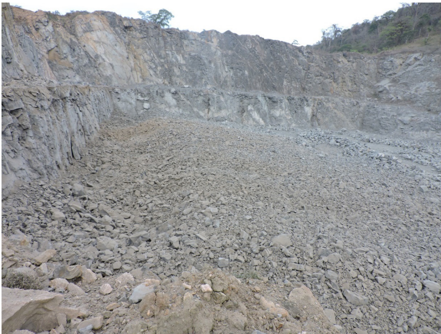
Figura 5 – Resultado do desmonte executado em 10/01/2017 na Bancada 1N da Pedreira Esperança Ltda
