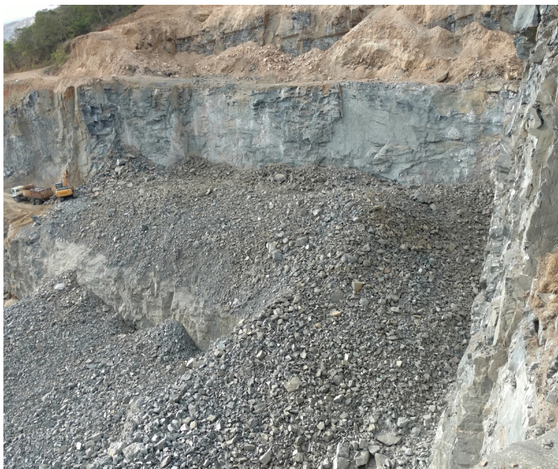
Figura 3 – Resultado do desmonte executado em 05/11/2016 na Bancada 2N da Pedreira Esperança Ltda
