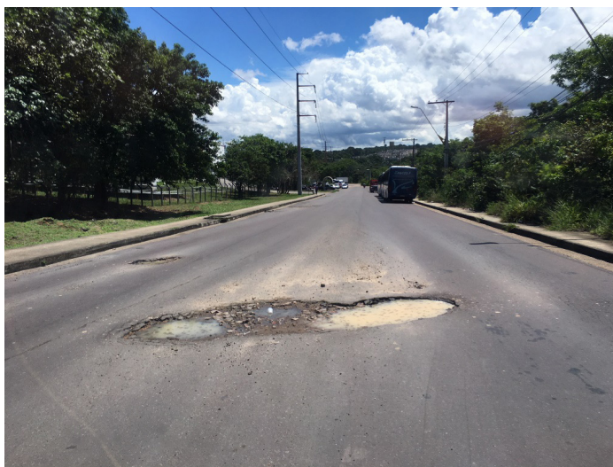
Imagem 3: Pavimentação da Avenida Otis
