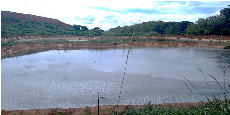
Figura 6: Sistema de tratamento de chorume atualmente instalado no aterro.
