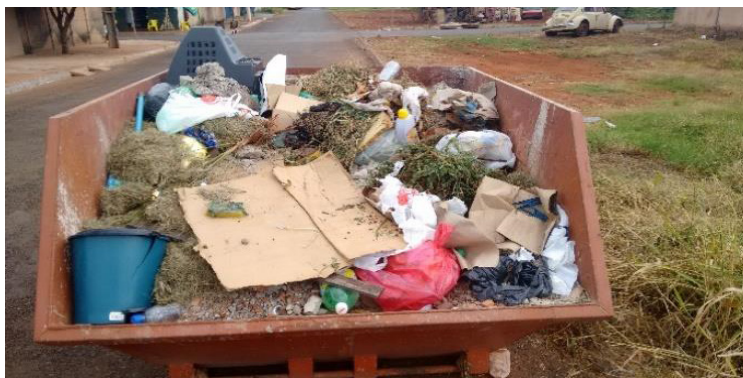
Figura 8: Caçamba de RCC's sem a segregação apropriada.
