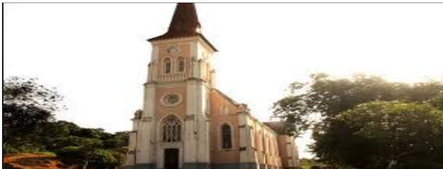
Imagem nº1: Foto da parte frontal da Igreja de São Tiago Maior de Lândana
