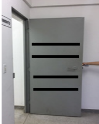
Figura 11 – Contraste nas portas da escada de emergência
