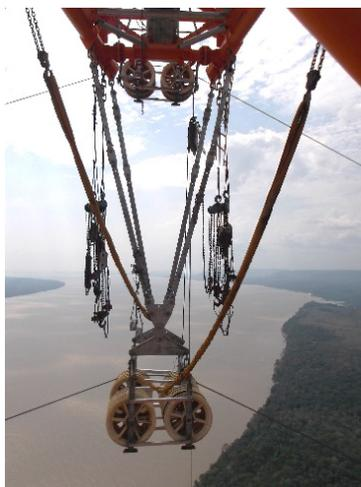
FIGURA 7 – Lançamento dos cabos
