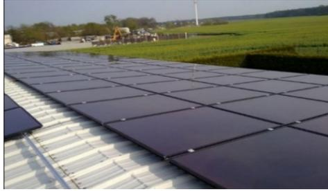
Figura 3 - Placas solares de filme-fino.
