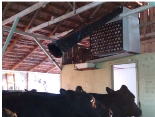
Foto 6 - Climatizador em operação
