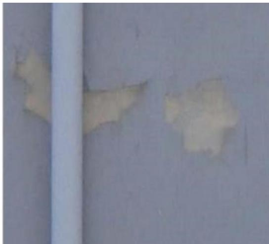
Figura 6 – Descascamento da tinta em revestimento de pintura.
