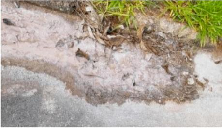
Figura 8: Boca de Lobo completamente obstruída
