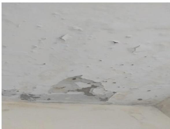
Figura 6- Infiltração causada pela água da chuva no teto da administração do condomínio
