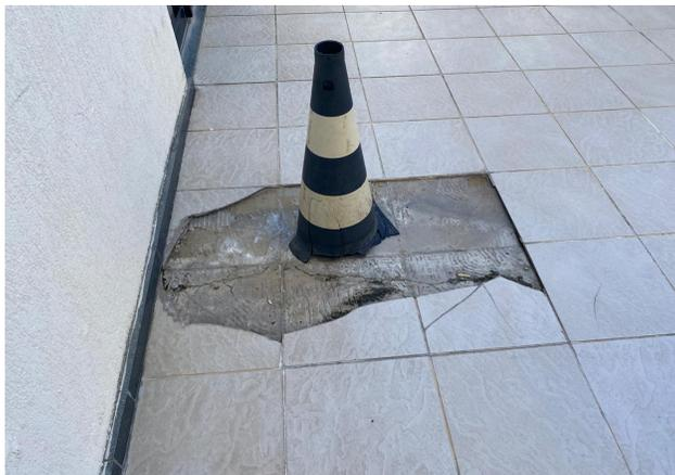
Figura 3- Deslocamento cerâmico nas áreas de circulação comum.
