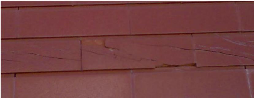
Figura 4 – Fissura na placa cerâmica do revestimento em parede externa.
