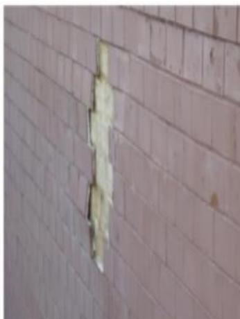
Figura 3 – Descolamento com empolamento de um grupo de ladrilhos em paredes exteriores
