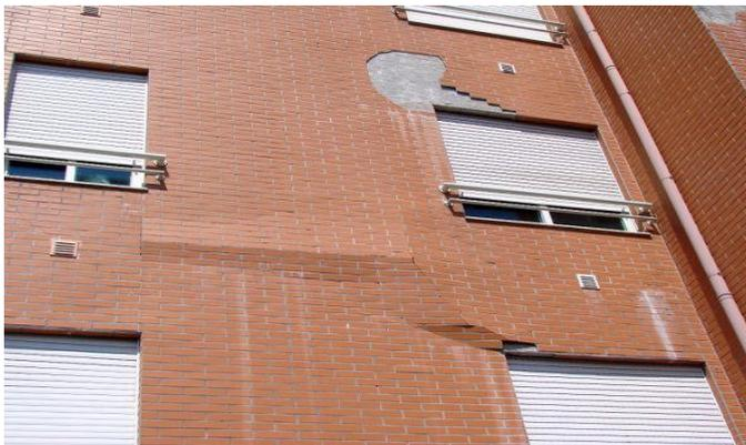
Figura 2 – Perda de aderência no revestimento da fachada de prédio.
