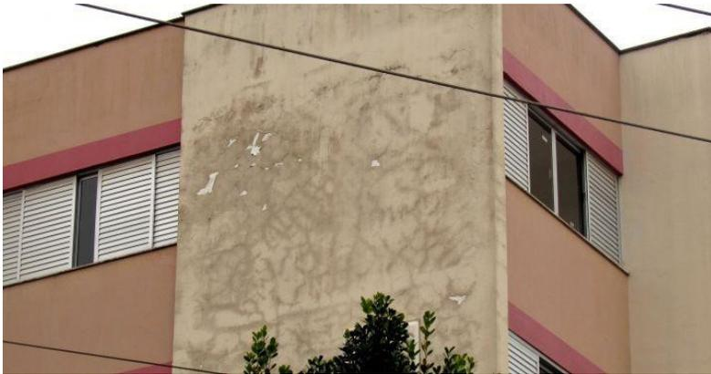
Figura 1 – Caso de fissura em revestimento argamassado.
