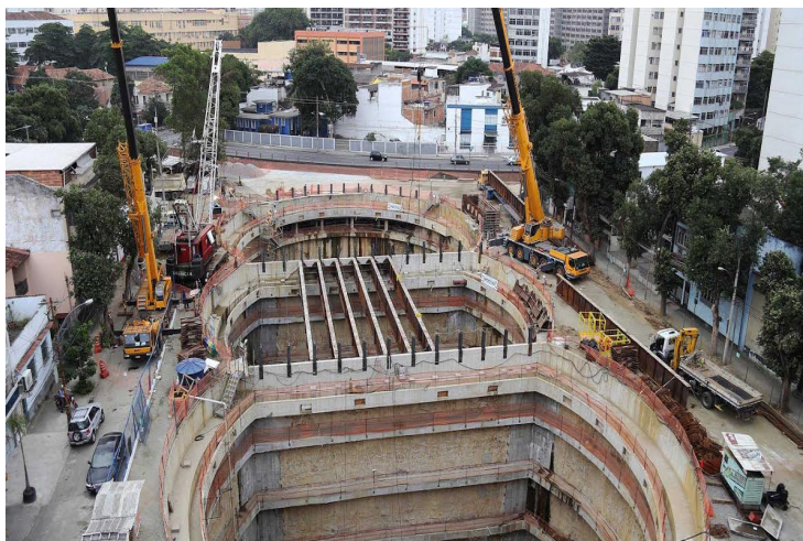
Figura 4: Obra (atualmente já concluída) do reservatório da Praça Niterói (Fonte: PCRJ)
