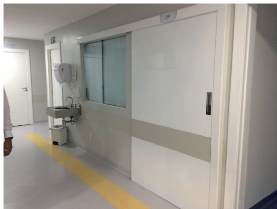
Figura 4. Parte externa do leito da UTI cirúrgica humanizada, isolado por paredes.
