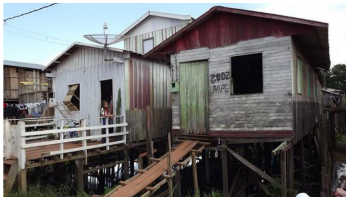
Fig. 3 - Habitação ribeirinha com vedações executadas a partir de tábuas verticais e horizontais, respectivamente.
