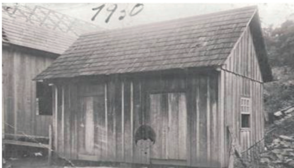
Imagem 2. Casa típica do Caboclo situada na vila de Perdizes, atual Videira.
