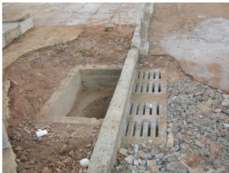
Figura 4 - Protótipo implantado na rua Pres. Wilson. Realizada em 08/2006
