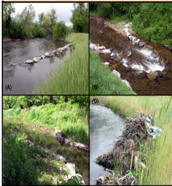
Figura 2 – Técnicas de restauração na calha – (a) espigão ou quebra-corrente de rocha (Rock vane); (b) espigão transversal (cross-vane); espigão longitudinal (double-wing); maço de raízes (rootwad).
