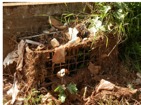
Figura 18 – Detalhe do orifício de fundo com o gradeamento
