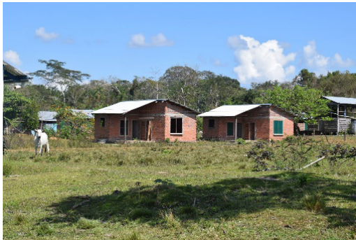
Aleros cortos y amplias ventanas elevan la temperatura interior
