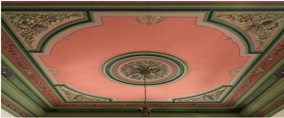
Figura 2 - Sala Pró Aliados – Museu Casa Rui Barbosa
