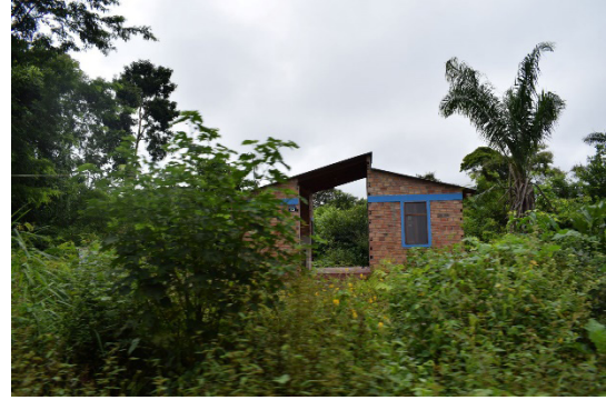
Vivienda nueva con cubierta metálica, notoria falta de adecuación al entorno.
