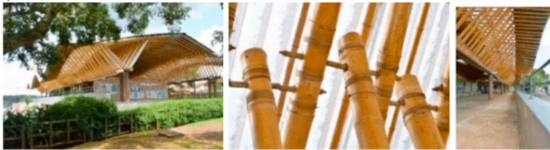
Figura 1 –A: Centro Cultural Max Feffer; B: Ligações de bambu com peças metálicas do Centro Cultural Max Feffer; C: Estrutura em V da cobertura de bambu e beiral da mesma.
