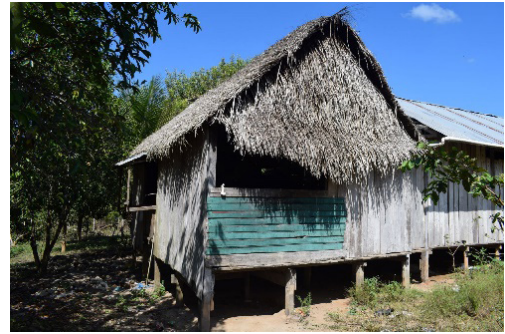
Resabios del sistema constructivo tradicional: protección solar y aislamiento de humedad.
