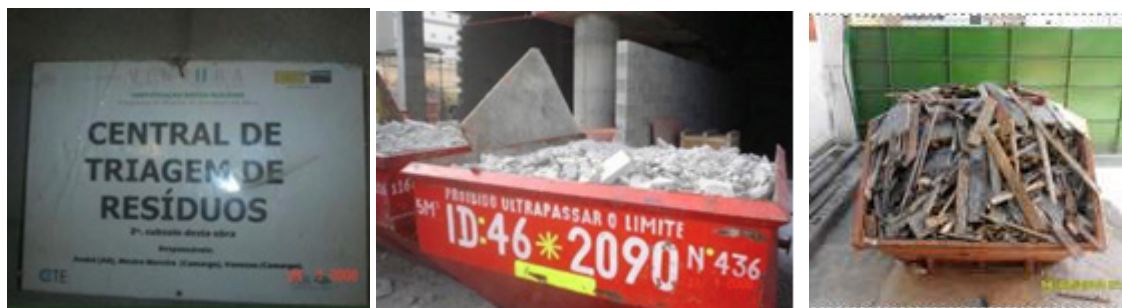
Figura 5- Triagem de resíduos durante a obra
