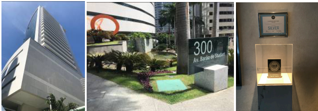
Figura 3- Fachada do edifício “A” e Placa de certificação
