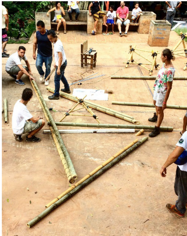
Figuras 19: Início dos trabalhos da construção da tesoura de bambu.
