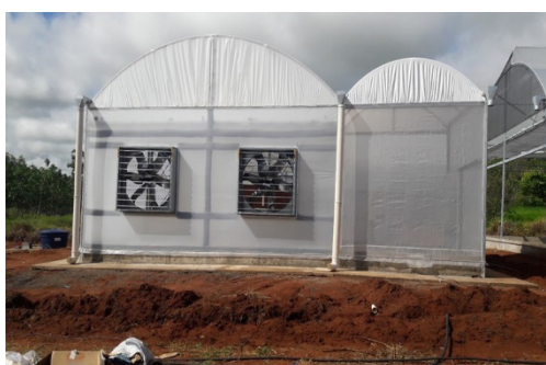
Figura 9. Casa de vegetação climatizada, com sistema de climatização pad fan. Cassilândia-MS, 2017.
